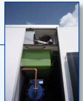
Compartiment technique comprenant le vérin d'ouverture de trappe, le réservoir d'humidification et le compresseur de climatisation
